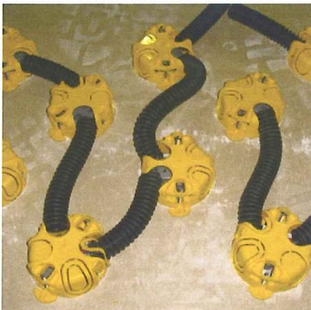
**Figure 8 – Raccordement par gaine des boîtes type « BATIBOX »**
