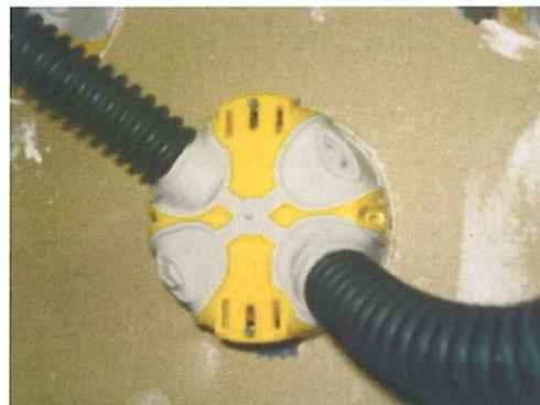
**Figure 9 – Raccordement par gaine des boîtes type « BATIBOX ENERGY »**
